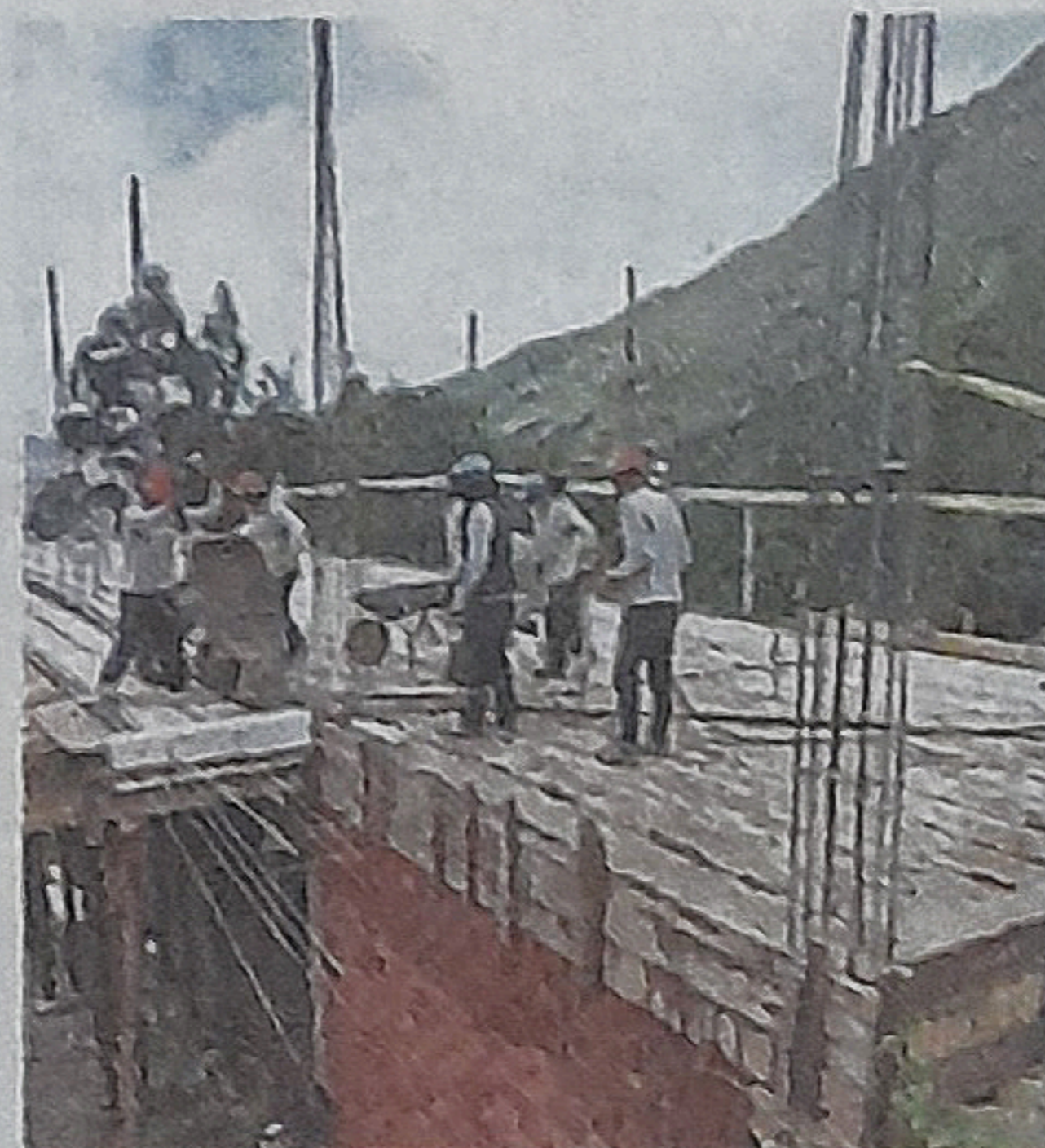
Arbeiten vor Ort am neuen Schulungszentrum
